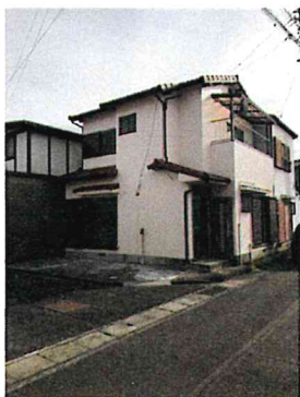
外壁塗装して綺麗になりました。玄関ドアも新品です。
